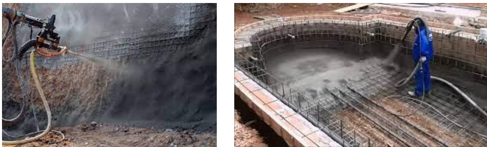
Figure I.8. Principe de la mise en place du béton projeté
