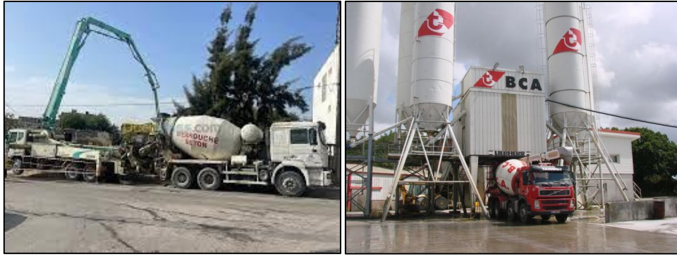
Figure I.9. Principe de fabrication et mise en place BPE
