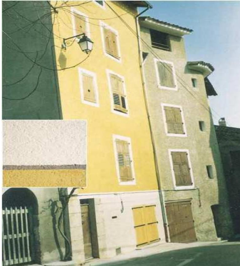
**Figure II.10.** Utilisation des chaux hydrauliques comme badigeons dans les constructions.
