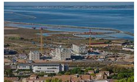
Constructions en cours près de l'étang de Thau (Sète, France).
