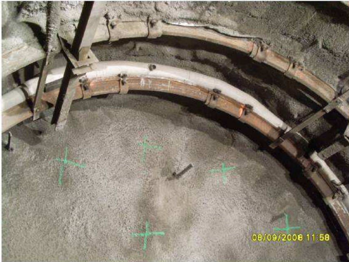
Cintres TH, boulons radiaux et béton projeté. Détail de la voûte d'une galerie du laboratoire
