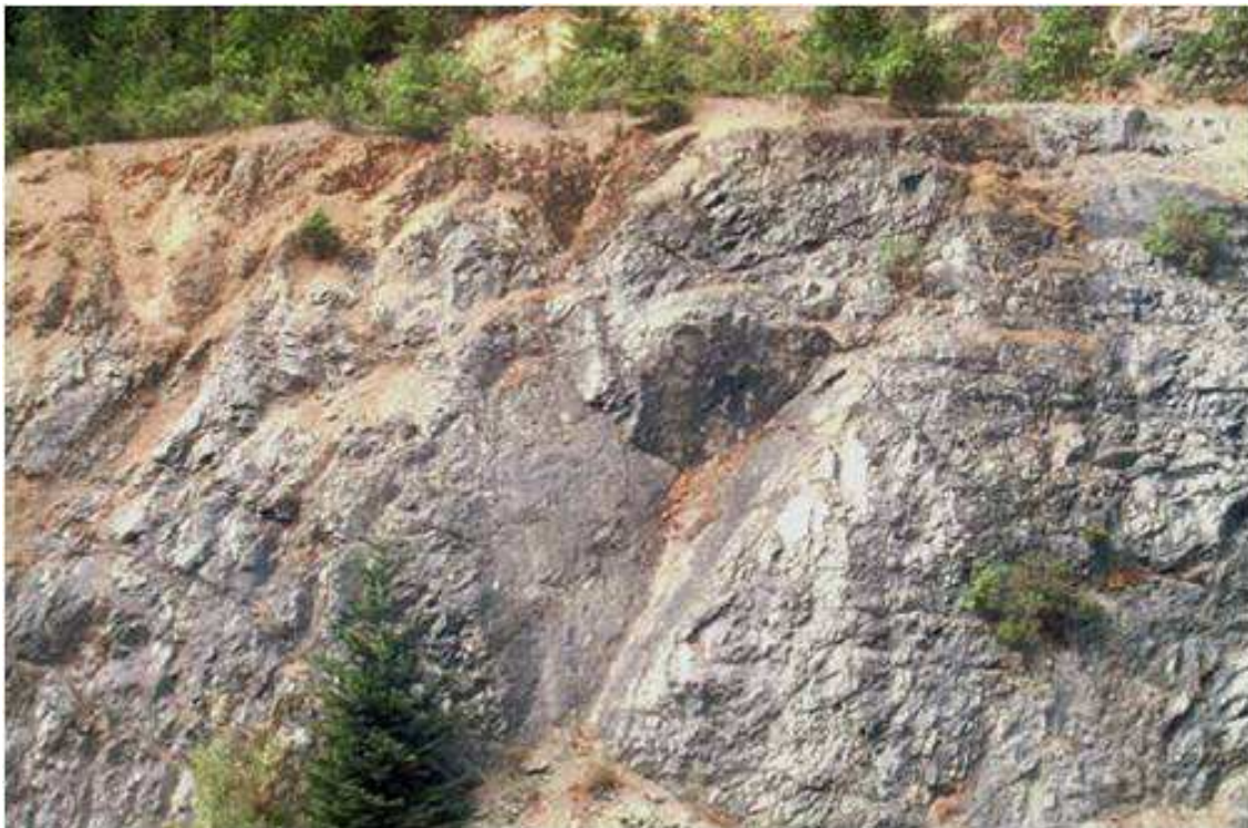
Rupture en dièdre
