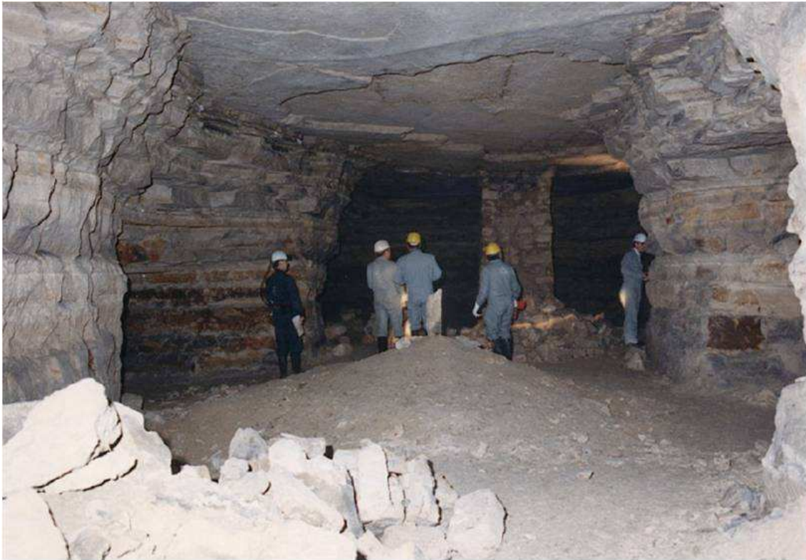
Rupture dans un massif stratifié
