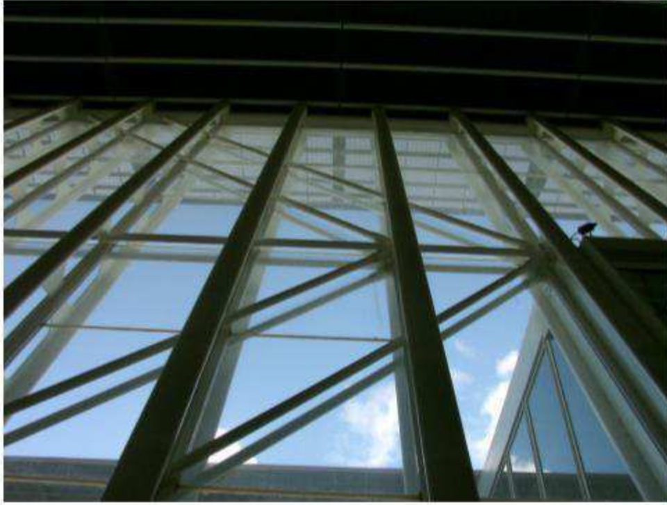
Figure 5 : Contreventement par tirants en triangulation
