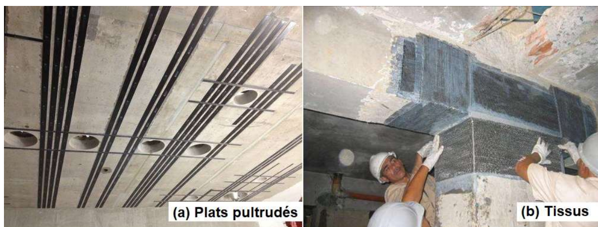
Figure 4 : Renforcement par des matériaux composites
