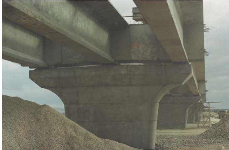
Poutres précontraintes préfabriquées sur chantier avant la mise en place du hourdis
