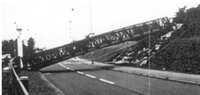
Passerelle emportée par un véhicule hors gabarit
