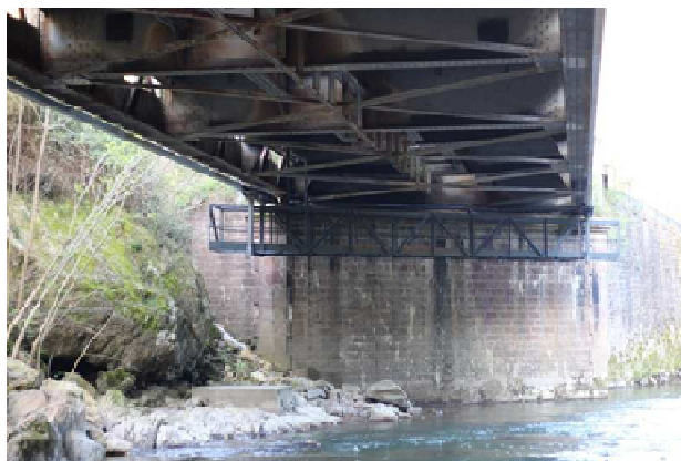
Passerelle de visite à demeure sur ouvrage métallique
