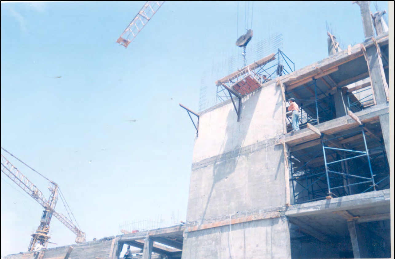
Fig.2 :Panneau de façade achevé de la hauteur d'un étage.
