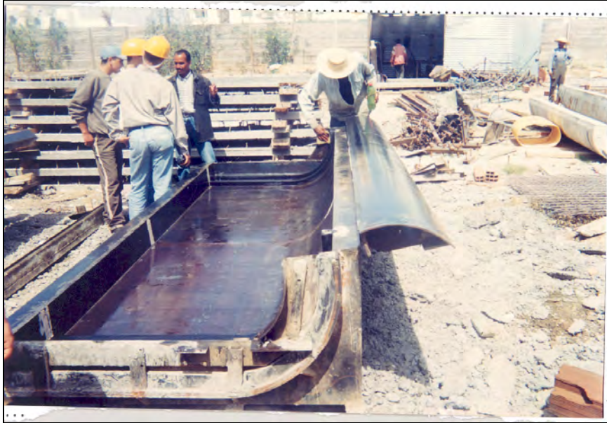
Fig.6 :Nettoyage et pulvérisation d'un agent de démoulage.
