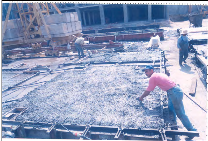
Fig. 5 :Moulage horizontal :Réalisation manuelle de surfacage Cas d'une pré-dalle.
