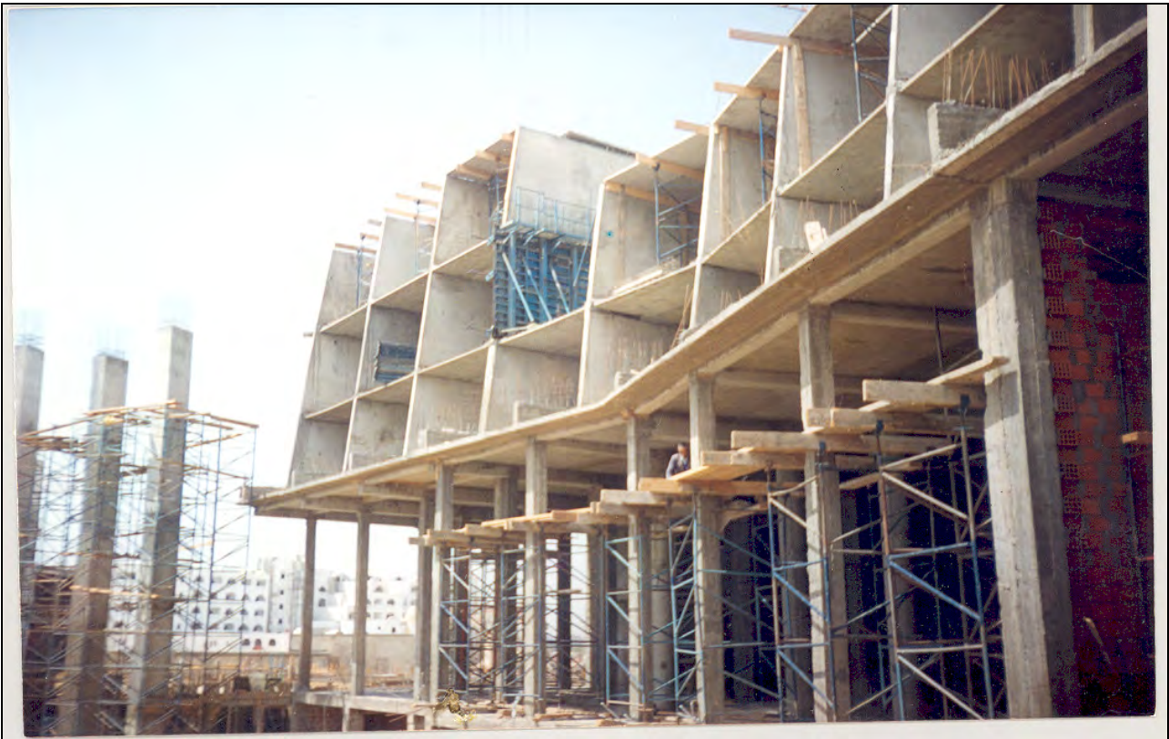
Fig.4 :Panneaux préfabriqués pour les murs intérieurs.
