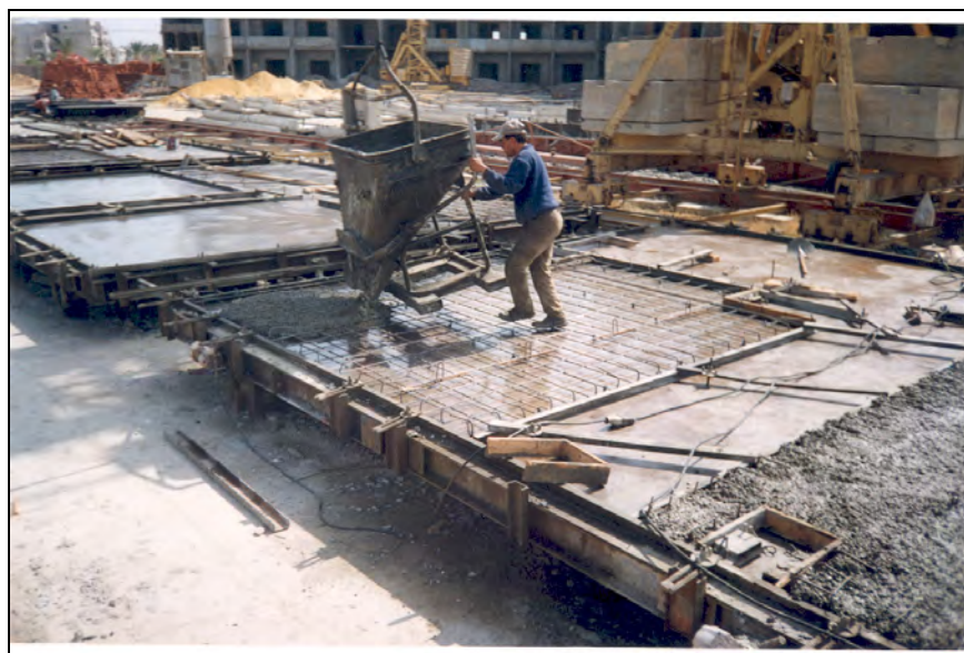
Fig.9 :Bétonnage d'un panneau :présence des encadrements des baies.
