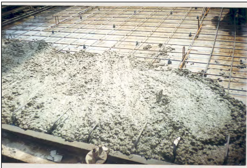
Fig.7 :Les armatures de fond du moule sont munies de cales.
