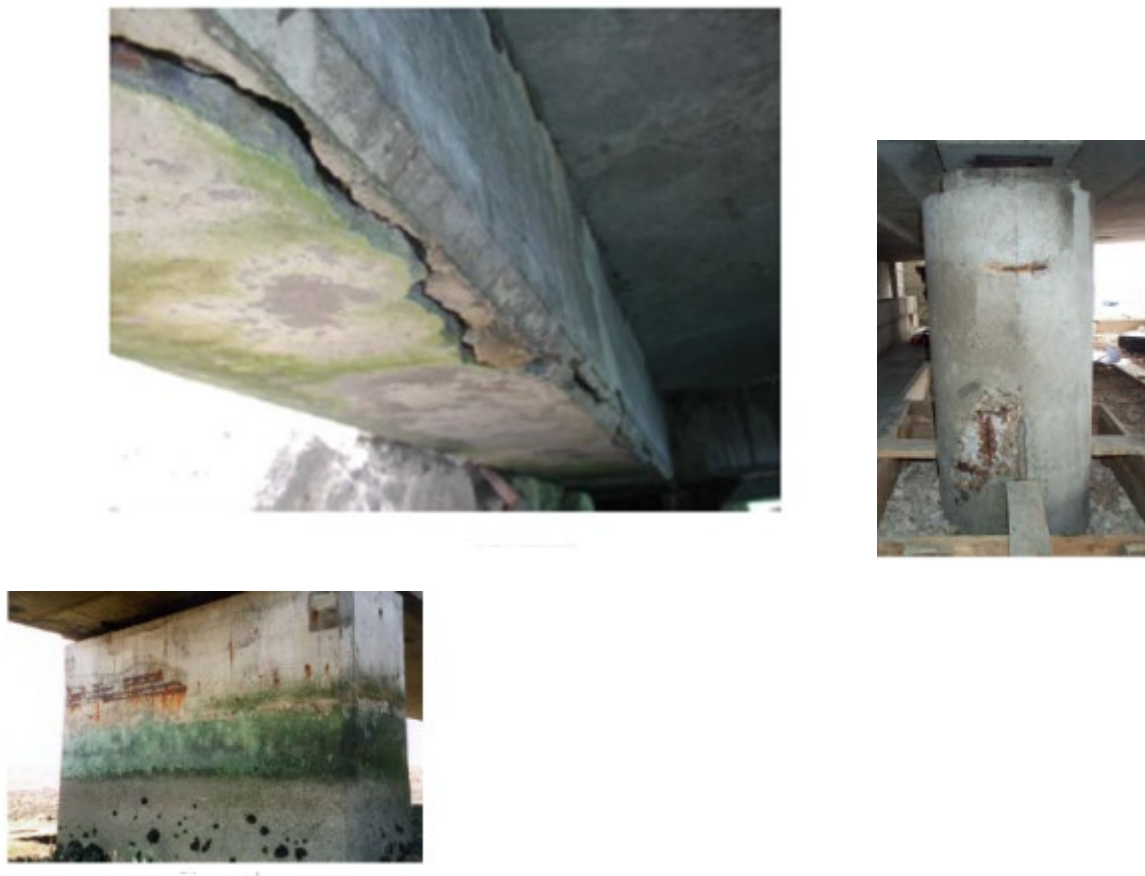
Figure II -14: Quelques photos d'ouvrage en BA dégradés par l'eau de mer. [12]
