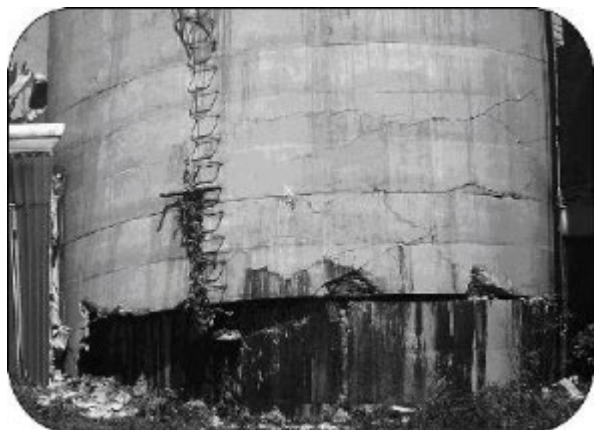
Figure II -10 : La détérioration des silos-tours en béton due à l'attaque des acides d'ensilage.
