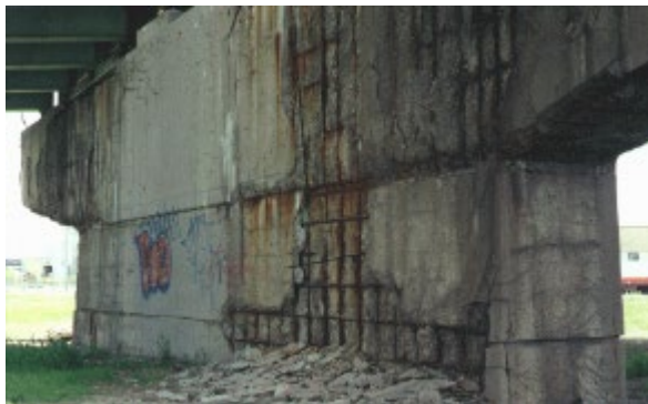
Figure II -18 : Agression du béton par activité des chlorures. [2]
