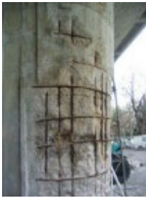
Figure II -28: Corrosion des armatures suite à la carbonatation du béton d'un pilotis.
