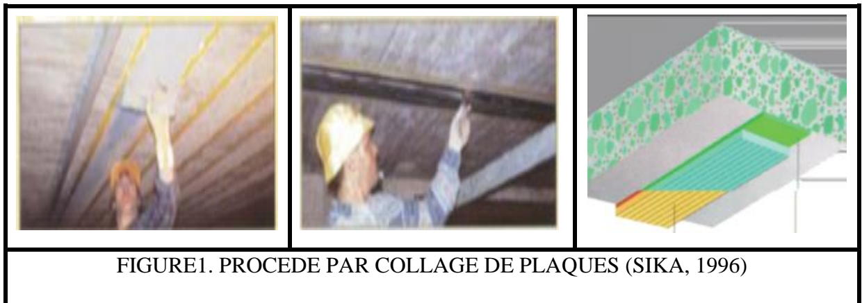
Figure III.6: Procède Par Collage De Plaques (SIKA, 1996).
