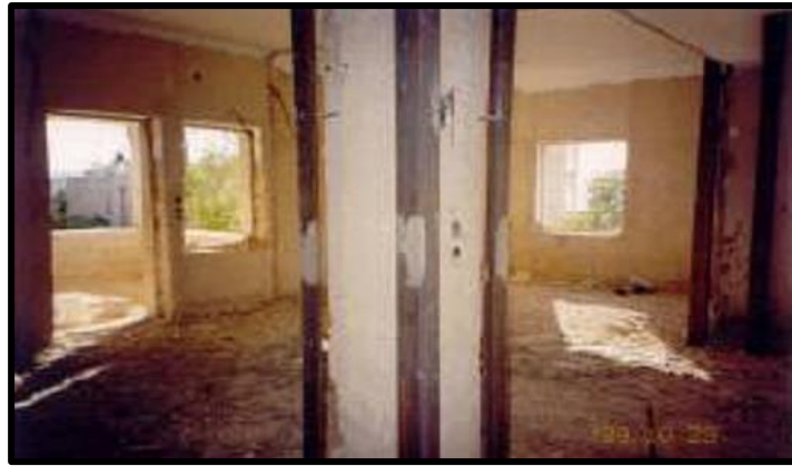
Figure III.7: Renforcement De Poteaux Au Moyen De Profiles Métallique. [18]
