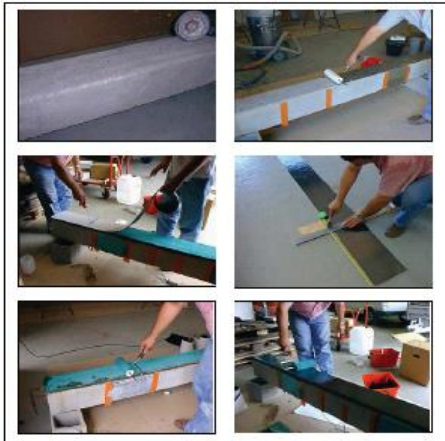
Figure III.5: Mise En Œuvre Par Stratification Directe.
