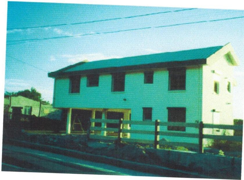
Fig. b. - Disposition incorrecte des éléments rigides par rapport au centre de gravité des niveaux. Les murs formant les panneaux de contreventement du rez-de-chaussée étant décentrés, ces constructions peuvent être soumises par les séismes à une torsion importante.
