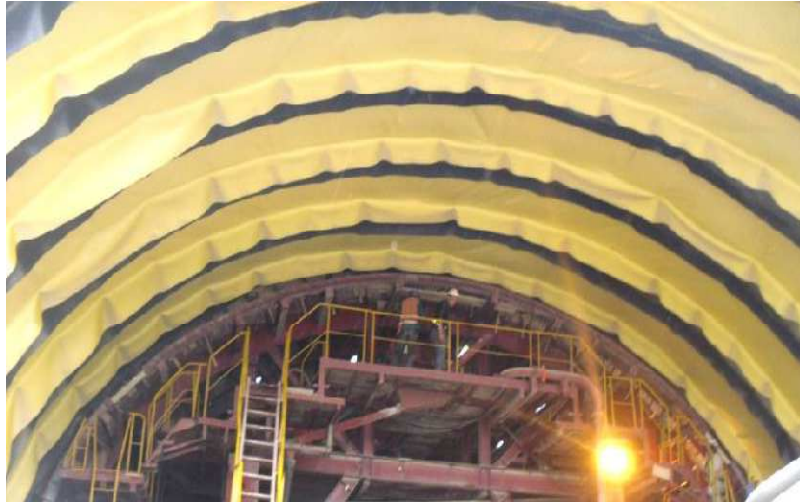
Mise en place du dispositif d'étanchéité
