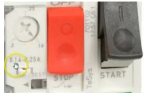
Figure 5.4 : Exemple de plaque signalétique et calibre d'un disjoncteur moteur
