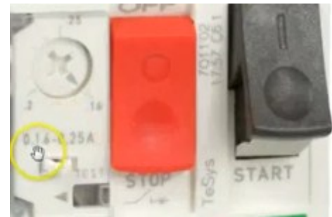
Figure 6.4 : Exemple de plaque signalétique et calibre d'un disjoncteur moteur
